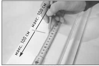
**2** Максимальное расстояние между светодиодными вкладышами — 100 см.
