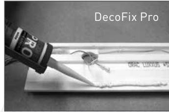
**7** Равномерно нанесите монтажный клей «DecoFix Pro» на обратную сторону изделия.
