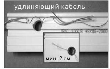
**4** Протяните провода через полученные отверстия.
